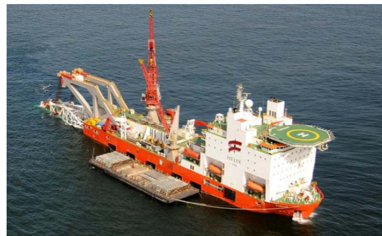
Caesar laying pipe offshore Trinidad GOM
